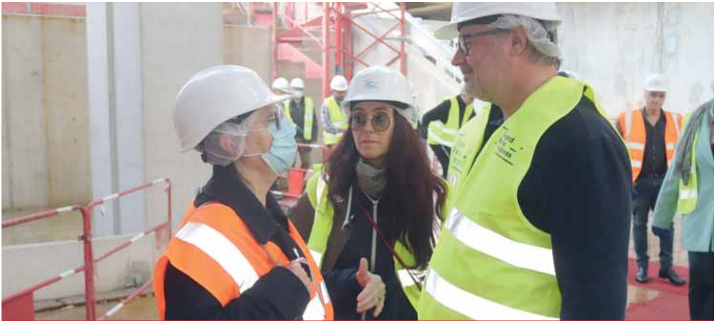
Visite de Maud Tallet, Annabelle Merlin et Guillaume Clin sur le chantier de la nouvelle gare.
