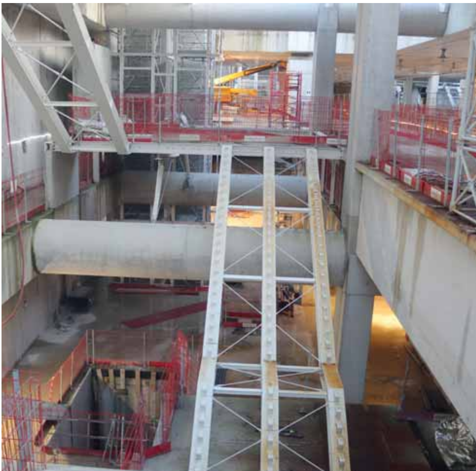
Dans le tunnel à Noisy-Champs, les traverses, caténaires, systèmes d'éclairage et rails sont installés, le tirage des câbles est en cours. Les rails vont désormais continuer à se déployer en direction des autres gares.
