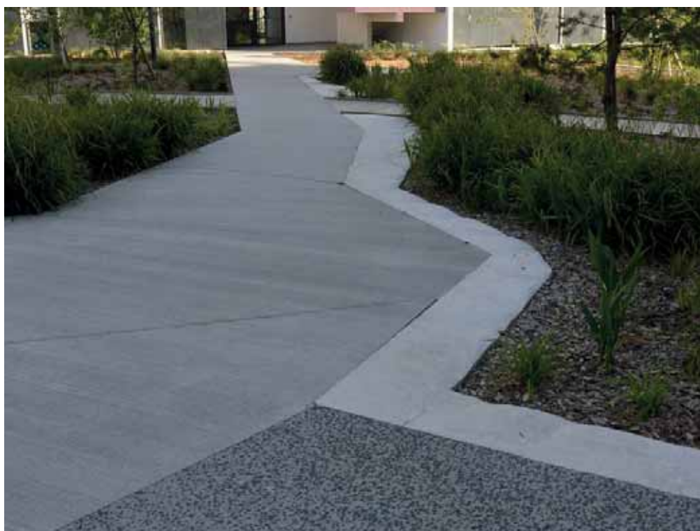
Cheminement en béton balayé
