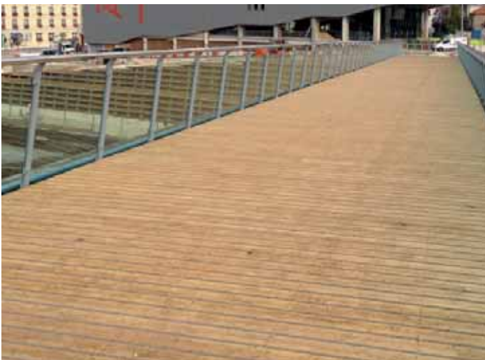
Terrasse en bois de chêne [teinte après pose]
