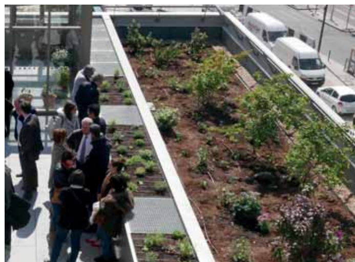
Garde-corps végétal sur toit.
