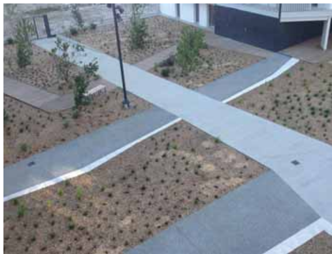
Cheminement en béton balayé
