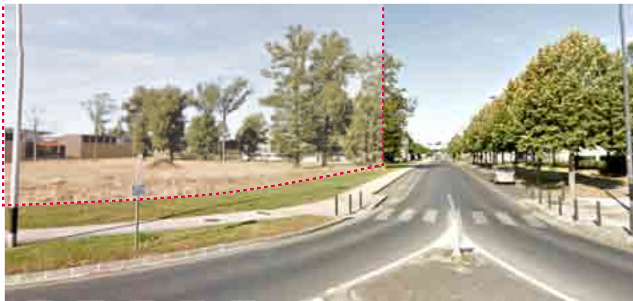
[PC7.4] - La parcelle V1 depuis la partie Est de l'Avenue Blaise Pascal.
