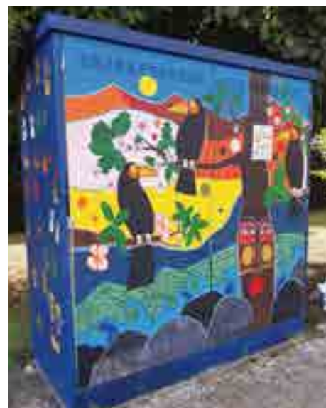
Armoire à gaz aux Deux Parcs Cette armoire à gaz, visible dès l'entrée du quartier des Deux Parcs, avait grand besoin d'être embellie. C'est pourquoi un paysage tropical y a été peint avec des toucans.
