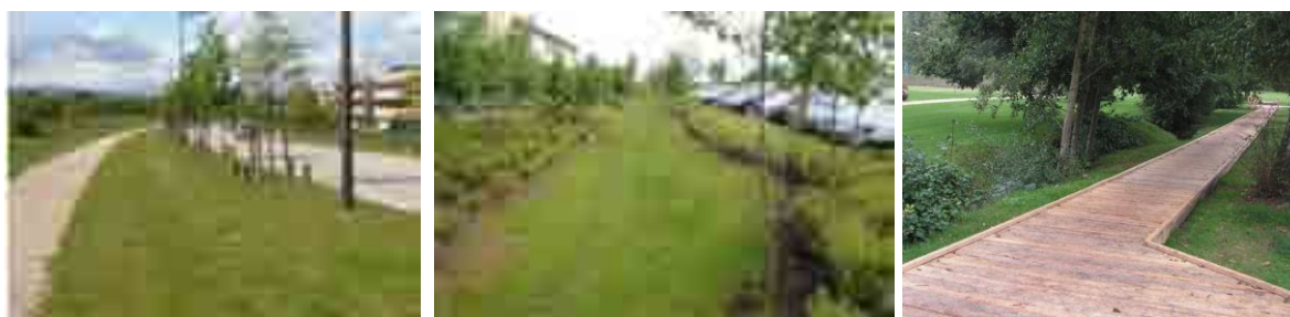
Exemples : noue engazonnée large- noue engazonnée avec massif de vivace – platelage bois pour le franchissement noue sur parking – Source : APS- Notice PAE et VRD
