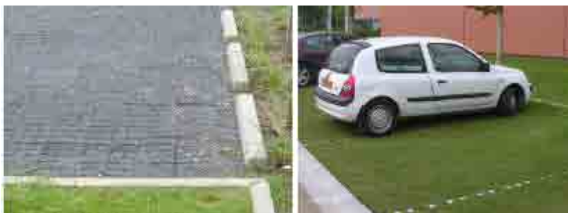
Exemples : stationnements dalle engravillonnée et stationnement dalle engazonnée- Source : APS- Notice PAE et VRD
