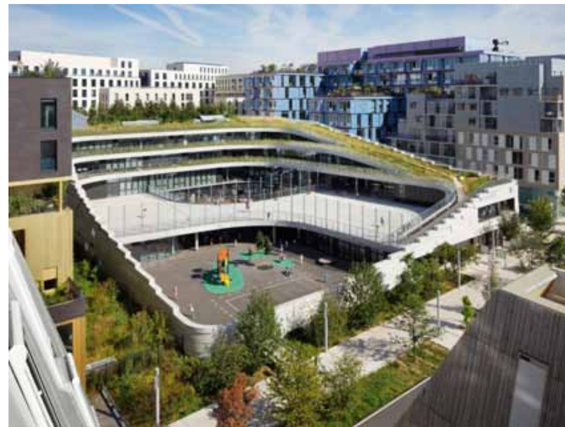
Figure 45: Exemple de toiture végétalisée (source : Groupe scolaire à Boulogne Billancourt Chartier Dalix)
