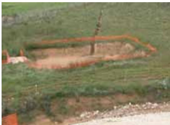
Figure 38: Exemple de fossé de collecte des eaux de chantiers à faible pente (Cerama 2015)
