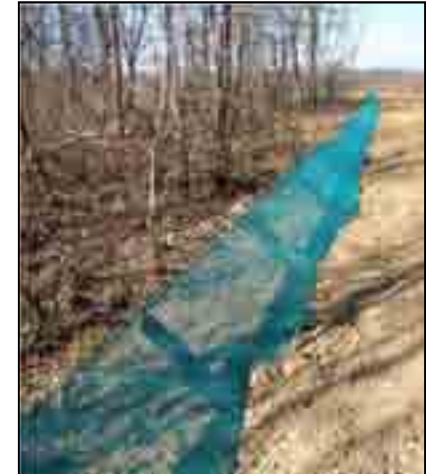
Mise en place de barrières amphibies
