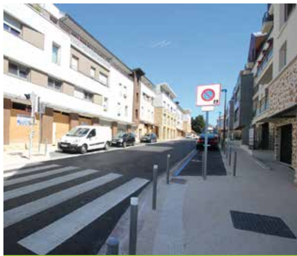
La rue de Paris terminée.
