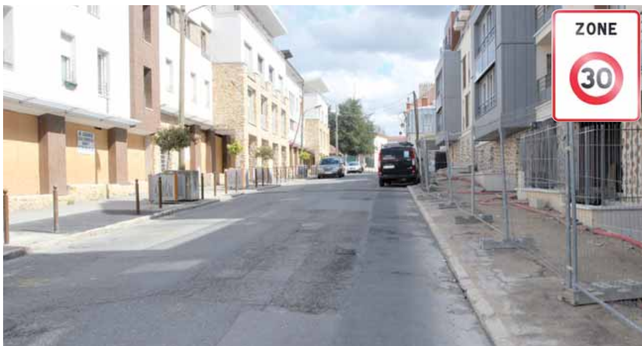
Quatre phases de travaux du 18 avril au 29 juillet 2016
